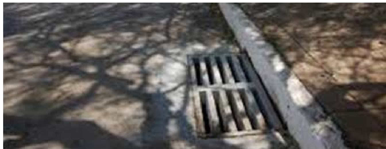
FIGURA 8: GRELHA METÁLICA INDICATIVA DE EXISTÊNCIA DE REDE COLETORA DE ÁGUAS PLUVIAIS 29
