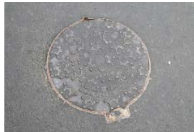
FIGURA 5: TAMPAS DE INSPEÇÃO INDICATIVAS DA EXISTÊNCIA DE REDE DE ESGOTAMENTO SANITÁRIO 19
