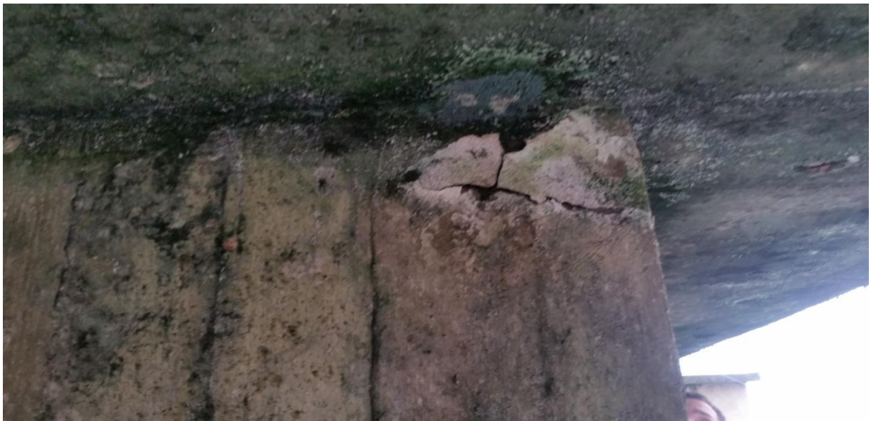
Fig. 5: Detalhe do topo do pilar P2.
