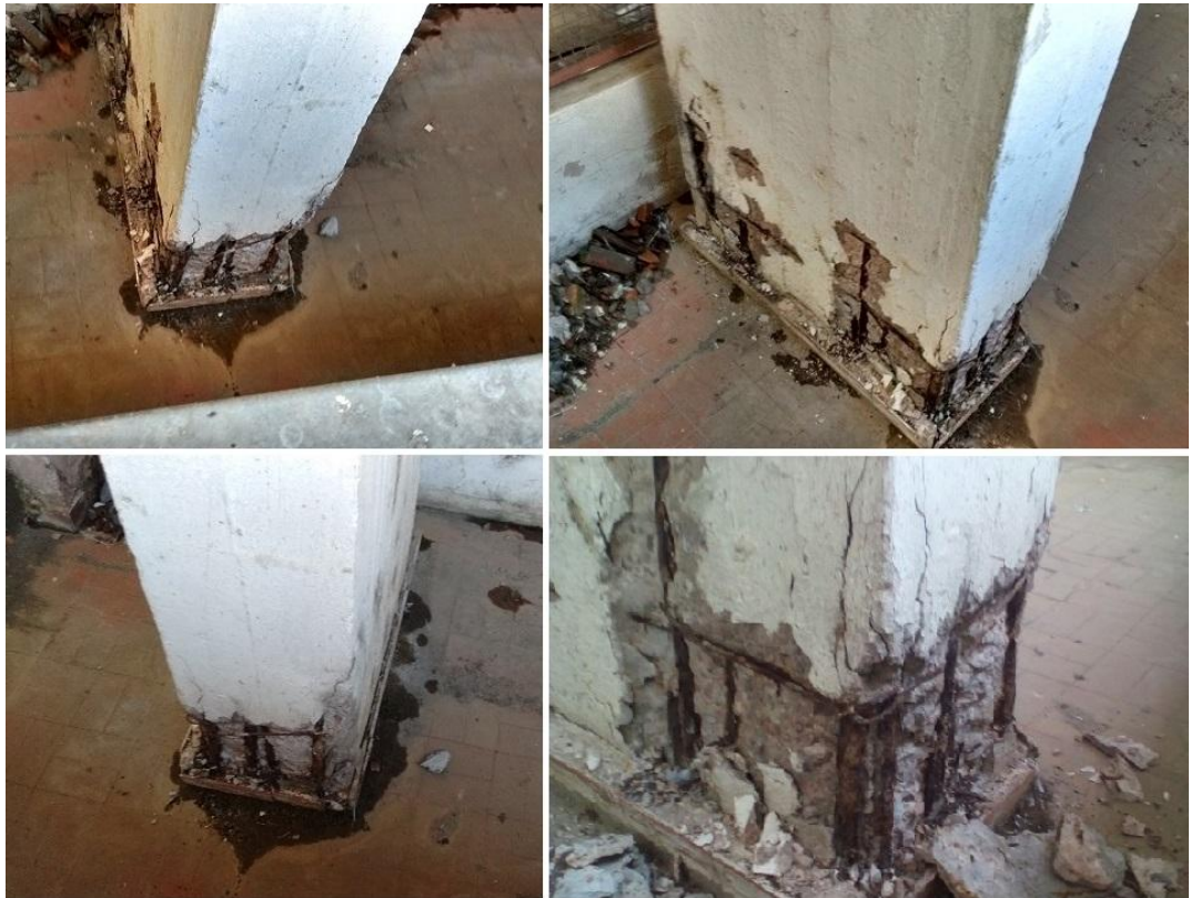
Fig. 2: Base do pilar P1.
