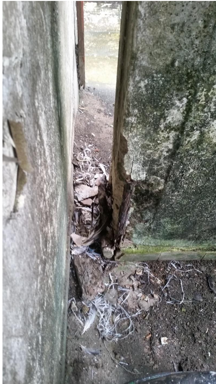
Fig. 6: Detalhe da base do pilar P3.
