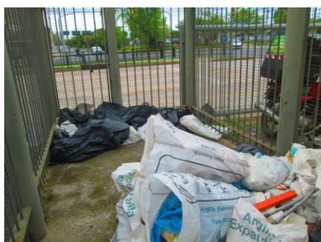
**Figura 23:** Armazenagem de RCC's
