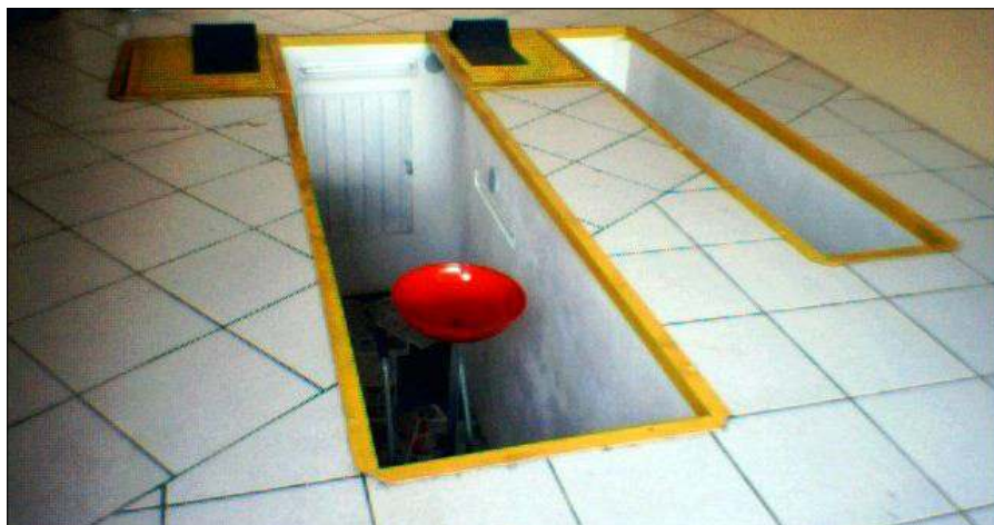
Poço de lubrificação impermeabilizado
