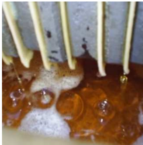
Óleo isolante mineral degradado
