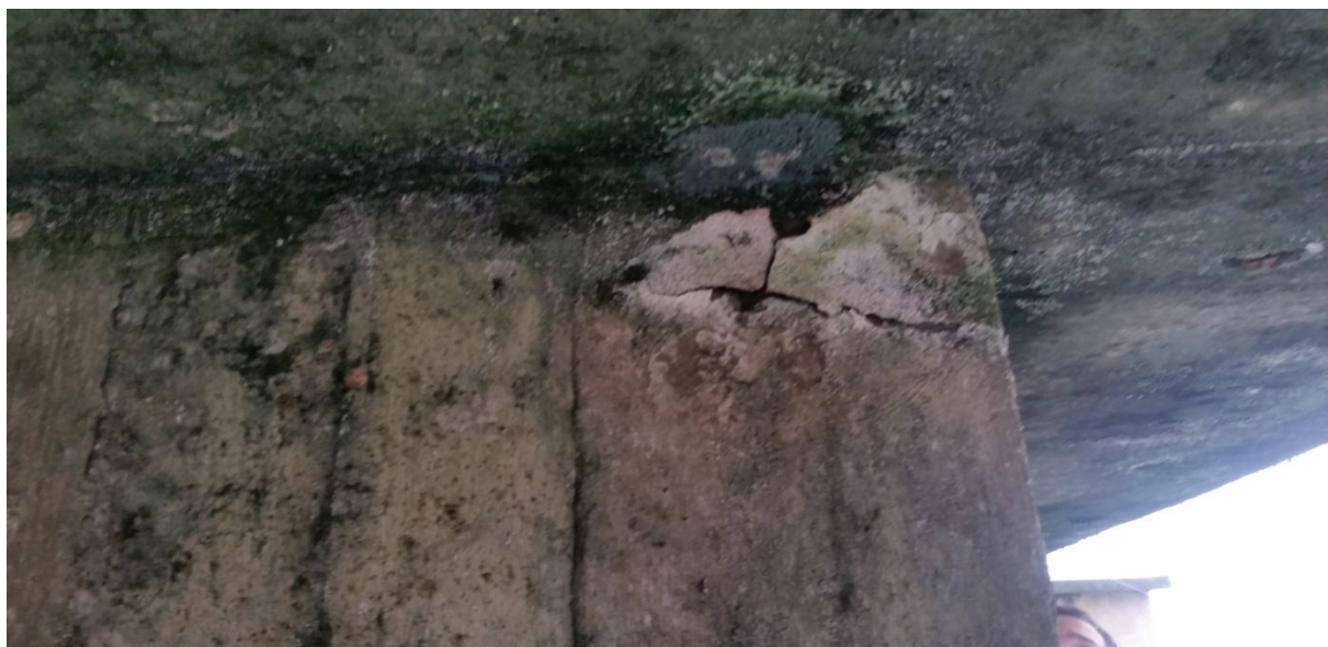
Fig. 5: Detalhe do topo do pilar P2.
