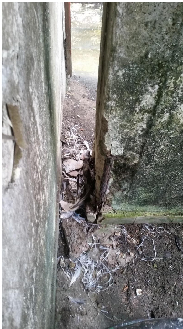
Fig. 6: Detalhe da base do pilar P3.
