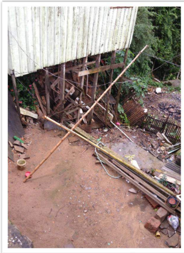
Casa em área de risco. Presença de detritos no terreno. (Fonte: autores)
